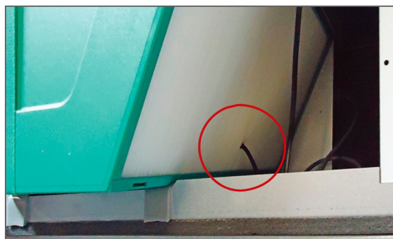
4. T4 føler trækkes ud af modstrømsveksler.
